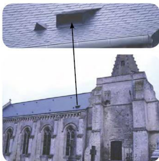
Photo 30. Exemple de chiroptière sur une église (Source : Guide CMNF)
